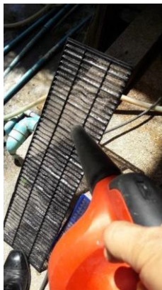
ขั้นตอนที่ 4 การเป่าแผ่นกรองอากาศและแผงครอบแผ่นกรองให้แห้ง
