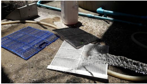
ขั้นตอนที่ 2 การล้างทำความสะอาดแผ่นกรองอากาศ
