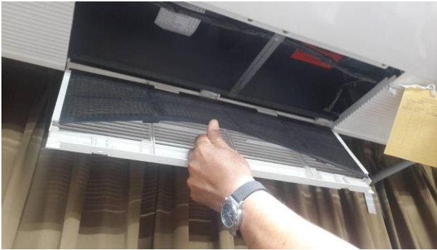
ขั้นตอนที่ 2 การล้างทำความสะอาดแผ่นกรองอากาศ
